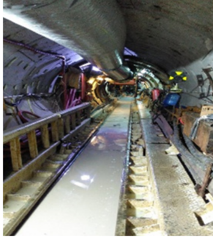
Şekil 16: Tünel A (Velimeşe ve Ergene1) Hattı inşaatı
