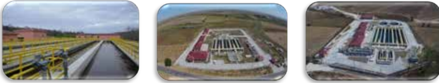
Şekil 7. TESKİ Malkara, Hayrabolu ve Saray Atıksu Arıtma Tesisleri.
