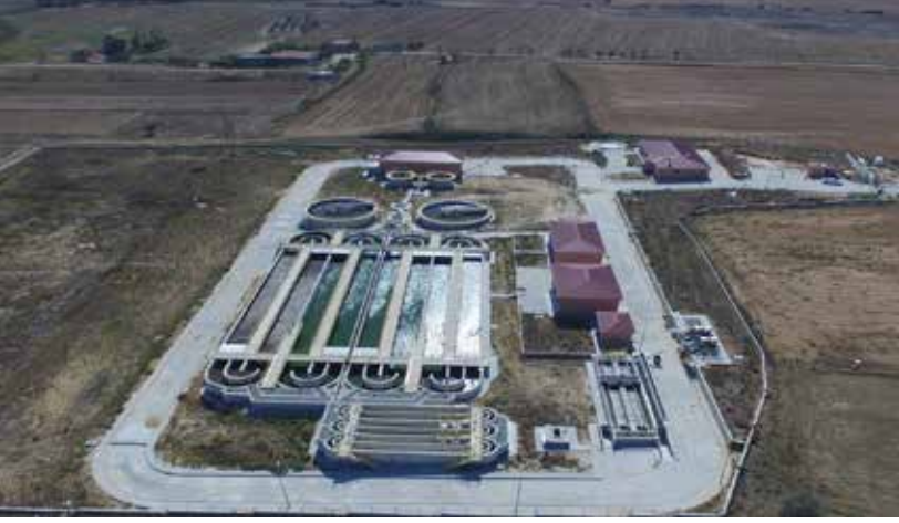
Şekil 1. Saray İleri Biyolojik Atıksu Arıtma Tesisi
