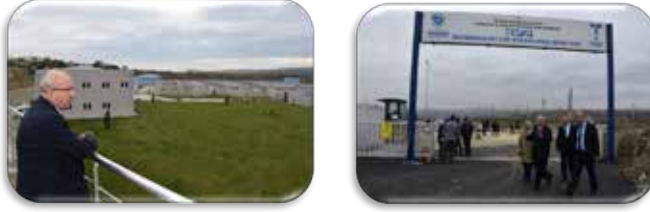
Şekil 6. TESKİ Batı Atıksu Arıtma Tesisi.
