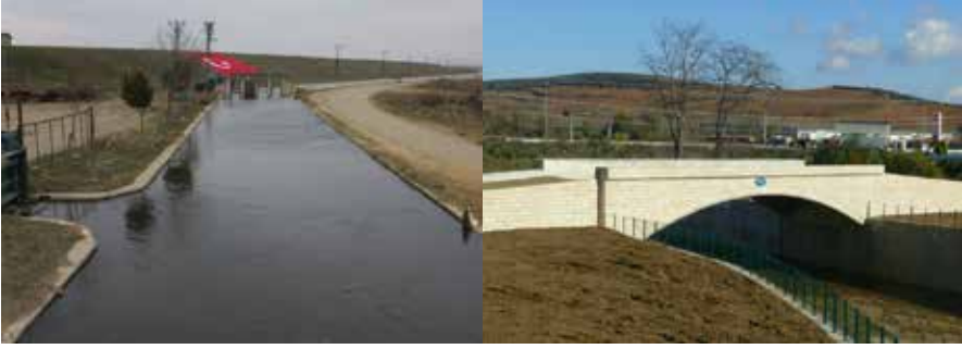
Şekil 5. Yenikarpuzlu Sulaması ve İncik Deresi Taşkın Koruma Yapısı
