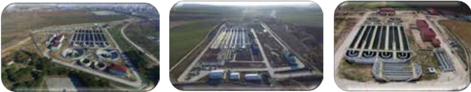
Şekil 8. TESKİ Muratlı, Çorlu ve Çerkezköy Atıksu Arıtma Tesisleri.
