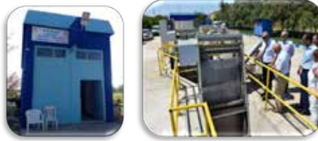
Şekil 10. Şarköy Derin Deniz Deşarjı Tesisi.
