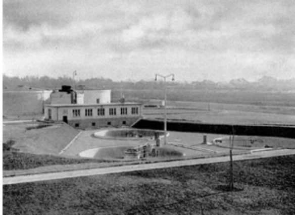
Figure 2- Kläranlage Gelbe Heide. © Landesbildstelle Wien/Niederösterreich
